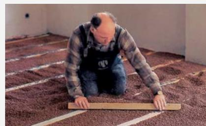
Liapor 4/8 bzw. Liapor 8/16 zwischen die Hilfskonstruktionen einfüllen und anschließend sauber abziehen.
