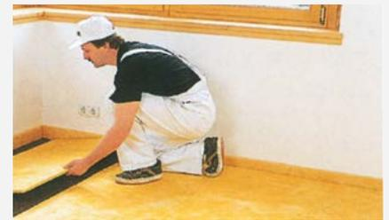
Trittschalldämmplatten mit einer dynamischen Steifigkeit von ca. 20 bis 40 MN/m<sup>3</sup>.
