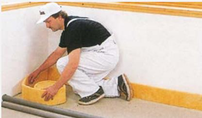
z. B. Feuchträume oder Bodenplatten erfordern eine Dampfsperre. Diese zuerst auslegen und im Bereich der Wand hochziehen. Randstreifen an der Wand, die zwei bis drei Zentimeter über den Fertigfußboden hinausragen, vermeiden Schallbrücken.
